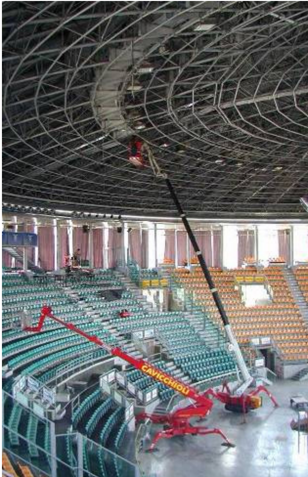
3 – Lavorazioni sulla struttura del coperto
