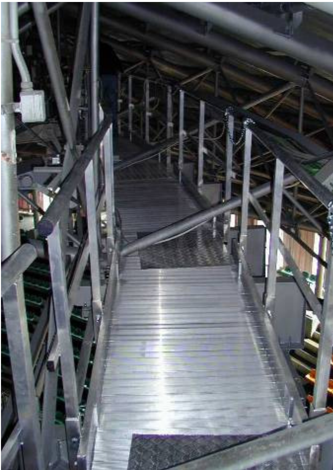
12 – Le nuove passerelle di servizio in alluminio
